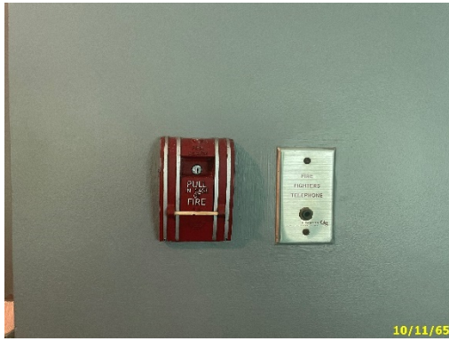
เครื่องแจ้งเหตุโดยใช่มือดึง (Fire Alarm Manual Station)
